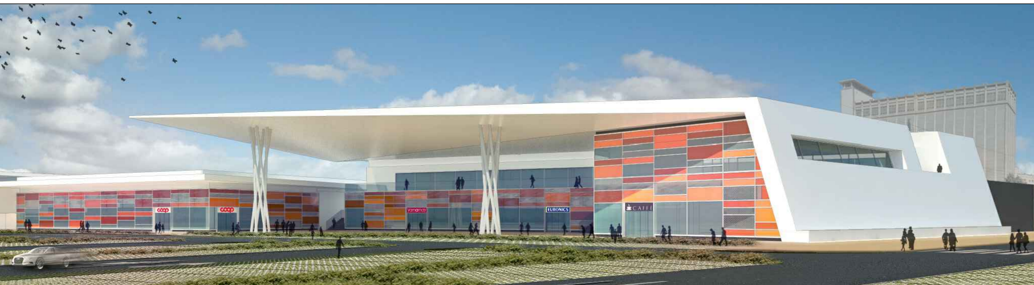
VISTA EDIFICI 1-2 VIA IV NOVEMBRE
