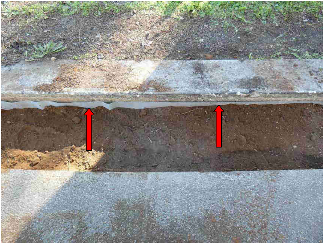
Area di scavo colmata e ricoperta a fine lavorazione. Notare (freccia) il bordo superiore della barriera antiradice a valle del ciglio.
