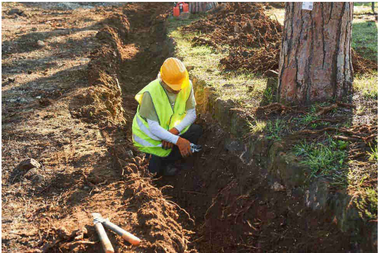
Potatura radicale dopo lo scavo della trincea
