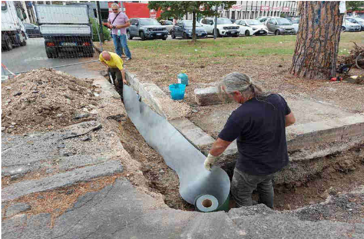
La barriera antiradice viene stesa nella trincea di scavo prima di essere tagliata e trattata.
