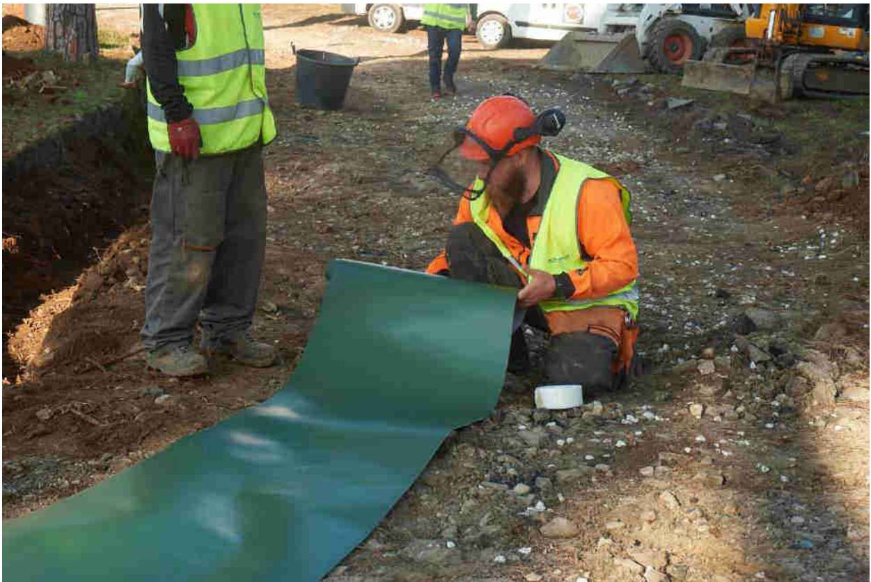
Preparazione della barriera radicale prima della sua messa in opera
