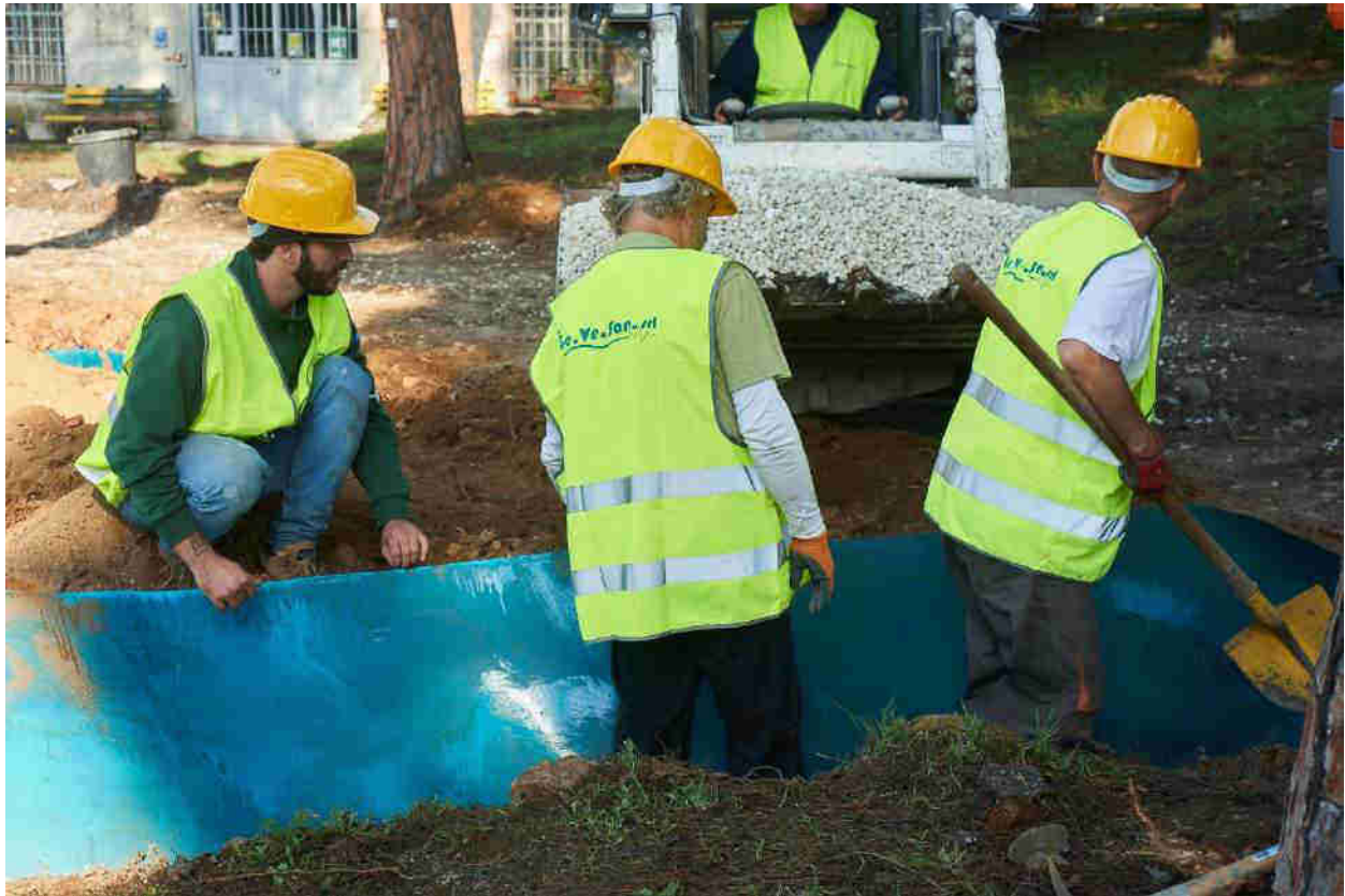
Messa in opera della barriera radicale
