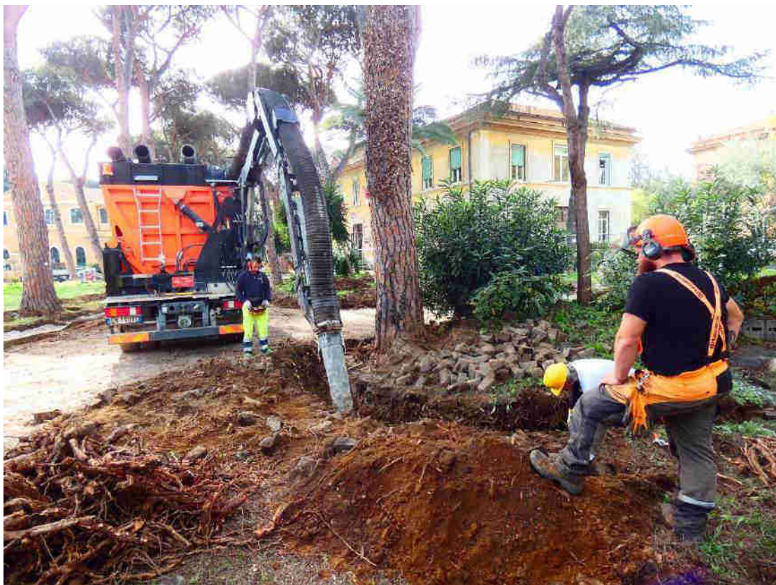
Scavo non invasivo con escavatore a risucchio Elephant
