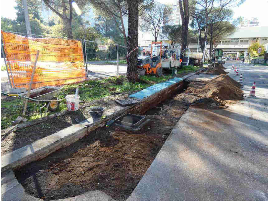
Sezione di scavo a lato strada a valle del ciglio prima della messa in opera della barriera radicale
