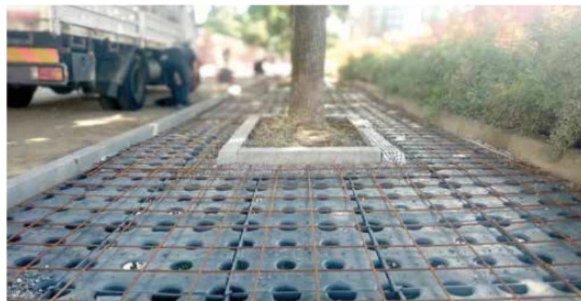
Esempio di salvaguardia del sistema radicale di piante esistenti in area interamente pavimentata con il sistema Cupolex Radici.
