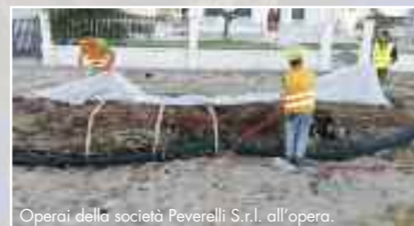
Operai della società Peverelli S.r.l. all'opera.
