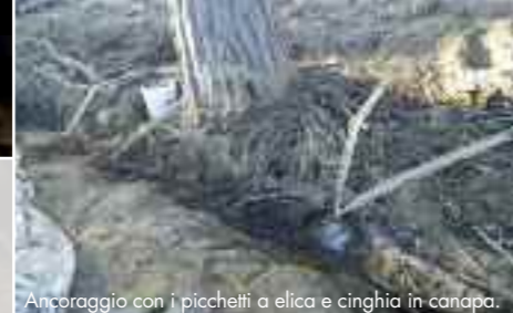
Ancoraggio con i picchetti a elica e cinghia in canapa.
