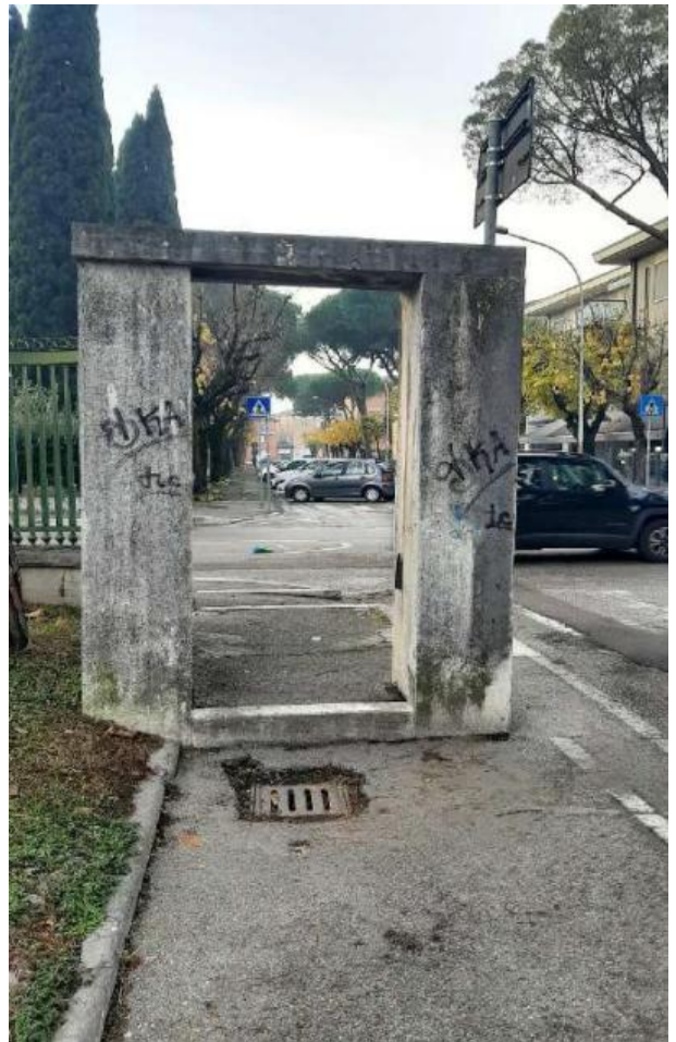
foto 25 _Dettaglio portali di ingresso Viale Giontella
