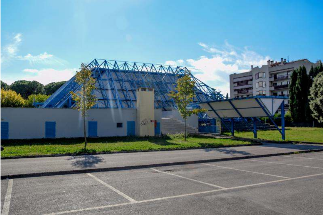
Bastia Umbra, G. Leoncilli Massi, Palazzetto dello Sport – Foto L. Tesei - Censimento Nazionale Architetture del Novecento, DGAAP, MiBAC
